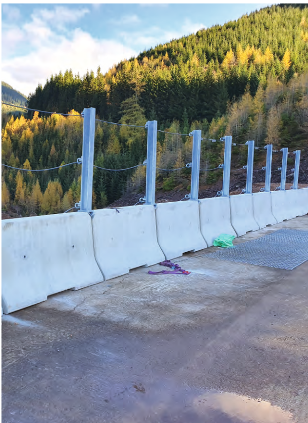
Foto 6: Danach Tragseile einziehen und spannen.
