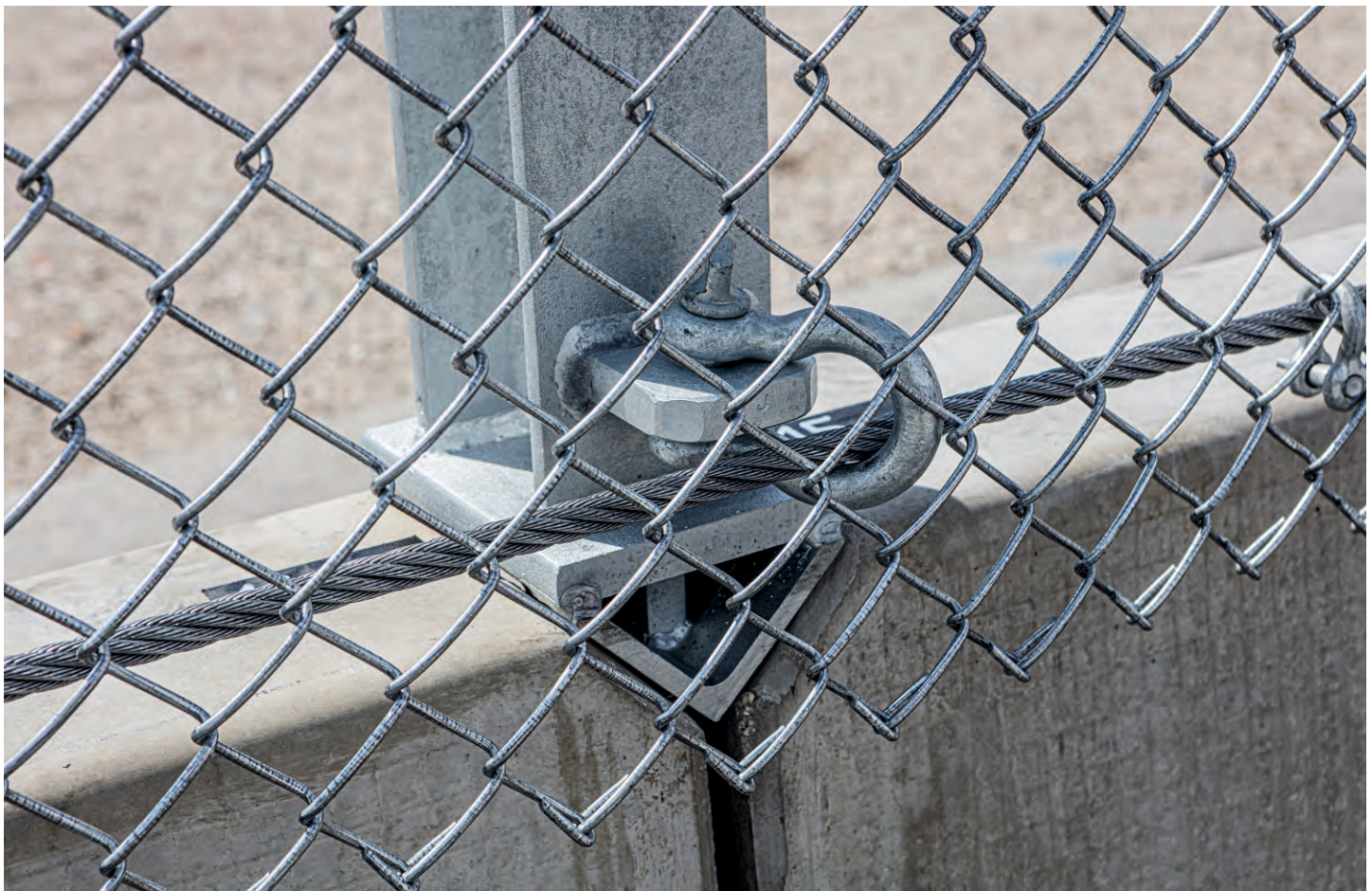
Foto 12: Detail Seilführung mit Stützenfuß
