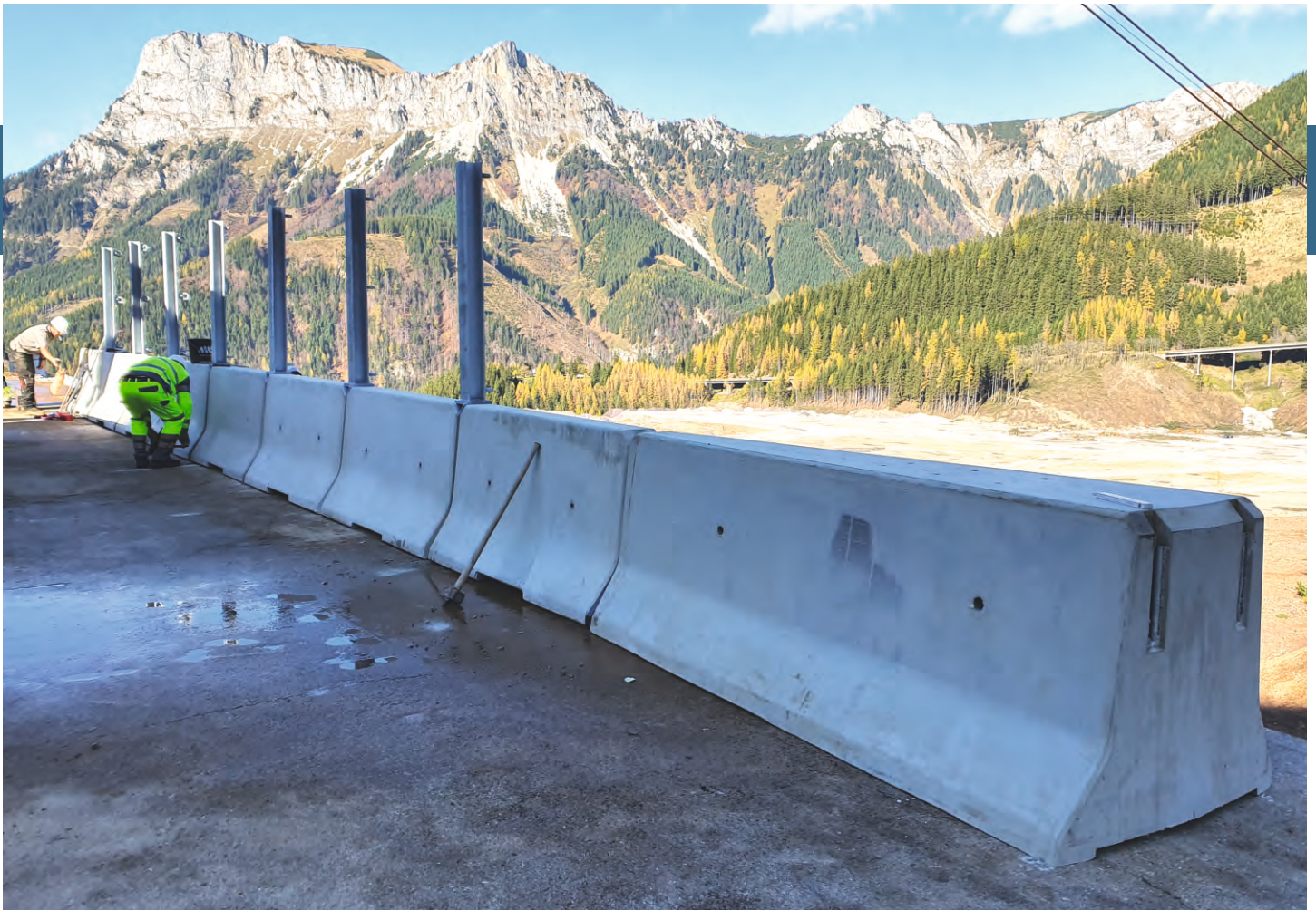
Foto 5: Alle Betonelemente werden mit den Stahlstützen als Verbindungsglieder montiert.
