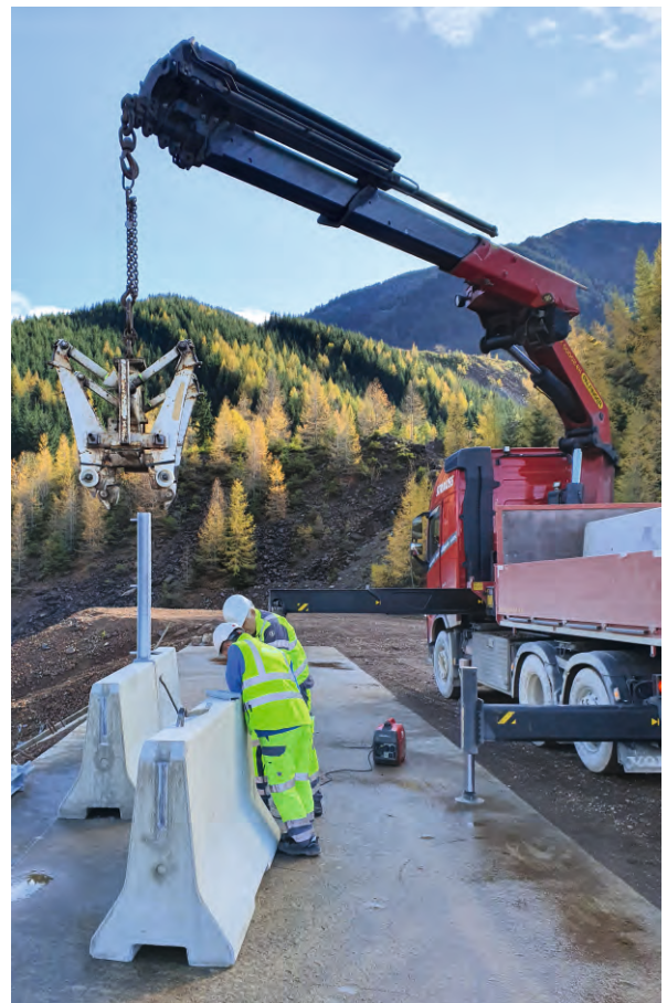
Foto 4: Versetzen der Betonfertigteile und Steher.
