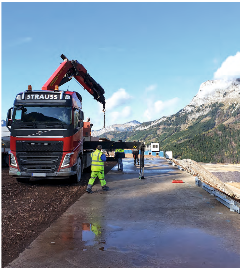
Foto 3: Eine solide Aufstandsfläche ist notwendig.
